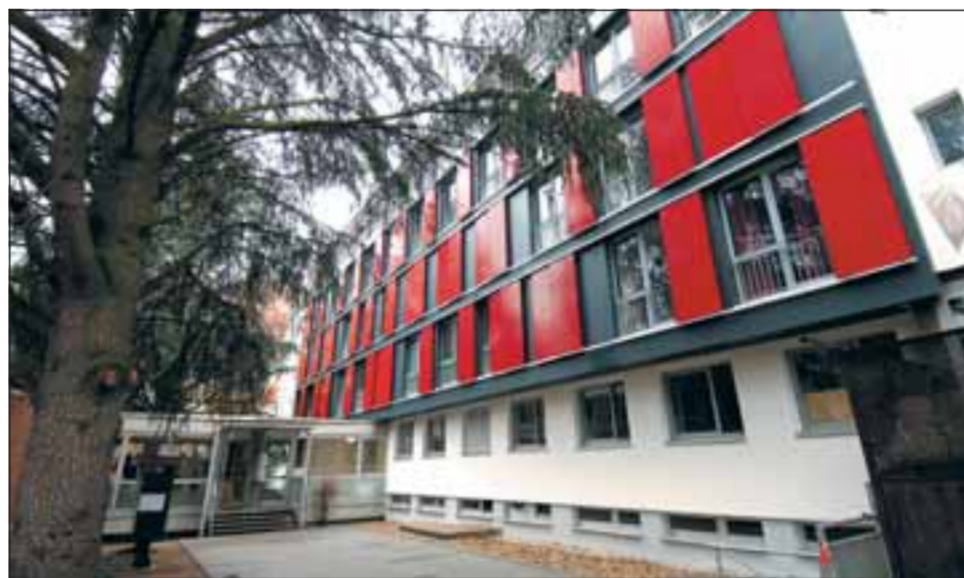
Mit einer „Grauwasseranlage“ hinter einer bunten Fassade und neuer Wärmedämmung erfüllt das Comeniushaus hohe Umweltstandards. Foto: Stefan Kresin
